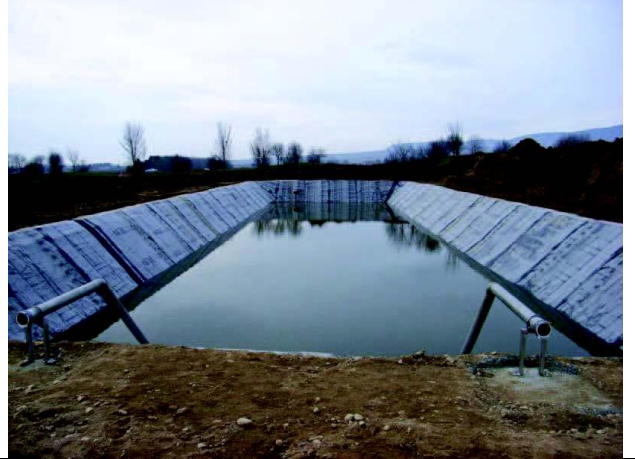
Réserve incendie 1500 m 3
