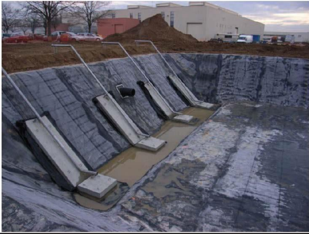
Réserve incendie 1500 m 3
