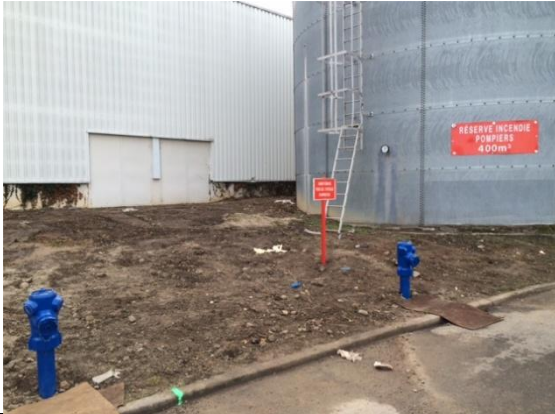
Réservoir aérien de 400 m 3 avec poteaux d'aspiration
