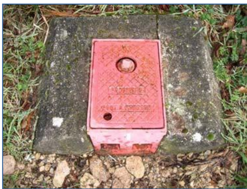
Bouche de lavage fermée
